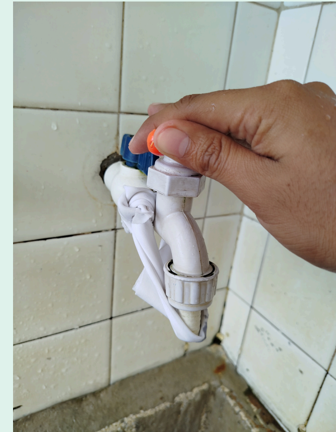
Colocación del filtro
