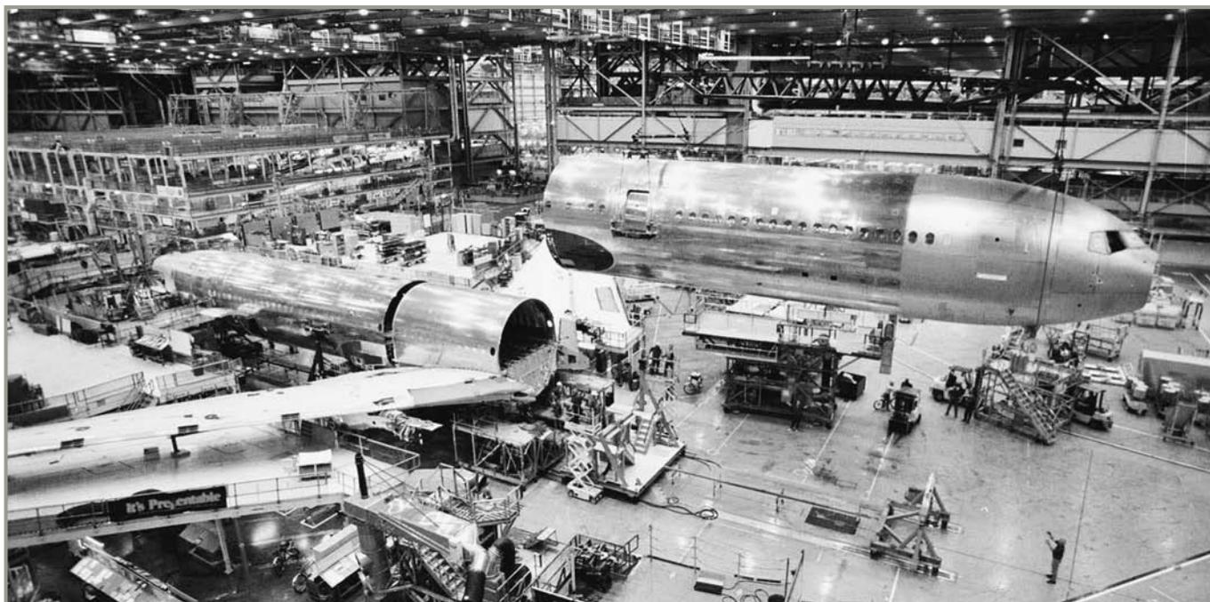
El esfuerzo de compras mundiales de Boeing da como resultado componentes que se unen en la línea de ensamble del 777 en Everett, Washington. Si bien los componentes llegan de todo el mundo, cerca de 20% de la estructura del 777 proviene de un consorcio japonés de Fuji, Kawasaki y Mitsubishi.
